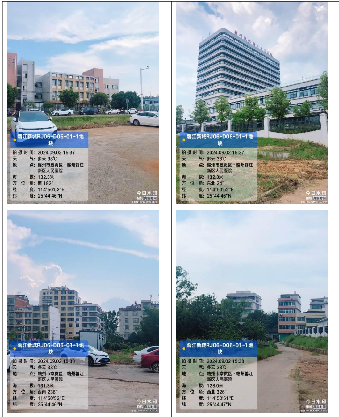
图 3.6-2 相邻地块现状照片
